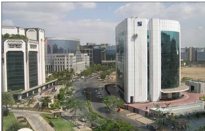
Nuevas oficinas en el complejo Bandra-Kurla en el sector norte de Dharavi
